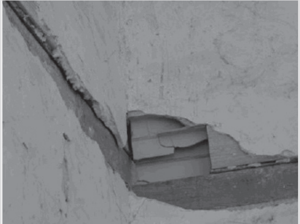
تصویر ۱۴: استفاده از تیرهای سرتاسری با فواصل مناسب برای تحمل بارهای ایجاد شده در پره‌های بادگیر و بلوک‌های سفالی برای سبک‌تر شدن پره‌های بادگیر
