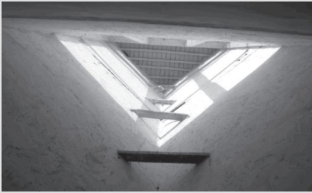
تصویر ۱۳: بست‌های چوبی در اتصال پره‌های بادگیر با فواصل کمتر
